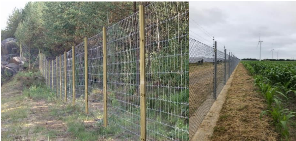
Kuva 2. Esimerkki riista-aidasta, jossa on puupylväitä (kuva vasemmalla) ja teollisuusaidan rakentaminen sisäpuolisella kiipeilysuojalla (kuva oikealla).
