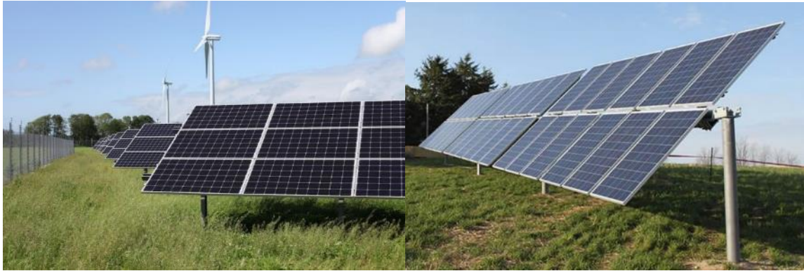
Kuva 3. Esimerkki piiaurinkokennomoduuleista, joissa on alumiinirunko maatalineessä (vasemmalla). Kuvassa Varbergs Energin Solsidan-puisto Tvååkerissa. Esimerkki aurinkokennomoduuleista yksiakselisissa aurinkoseurantajärjestelmissä (oikealla).
